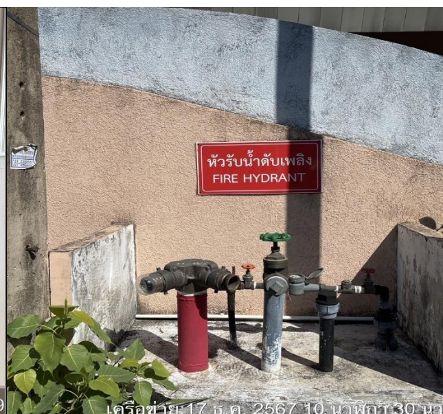
รูปที่ 2.4.7.3-2 หัวรับน้ำดับเพลิงภายนอกอาคาร
