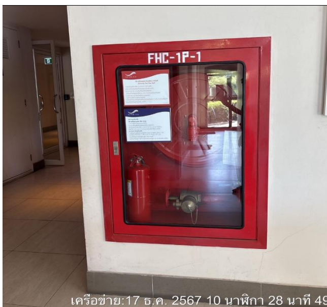
รูปที่ 2.4.7.3-1 ตู้เก็บสายน้ำดับเพลิงพร้อมอุปกรณ์
